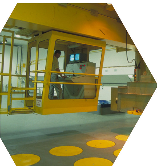
Site van Belgoprocess in Dessel - Opslaggebouw voor opwerkingsafval
