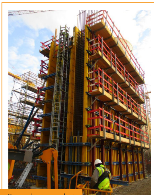
Bouwplaats van het SF 2 -gebouw in Tihange
