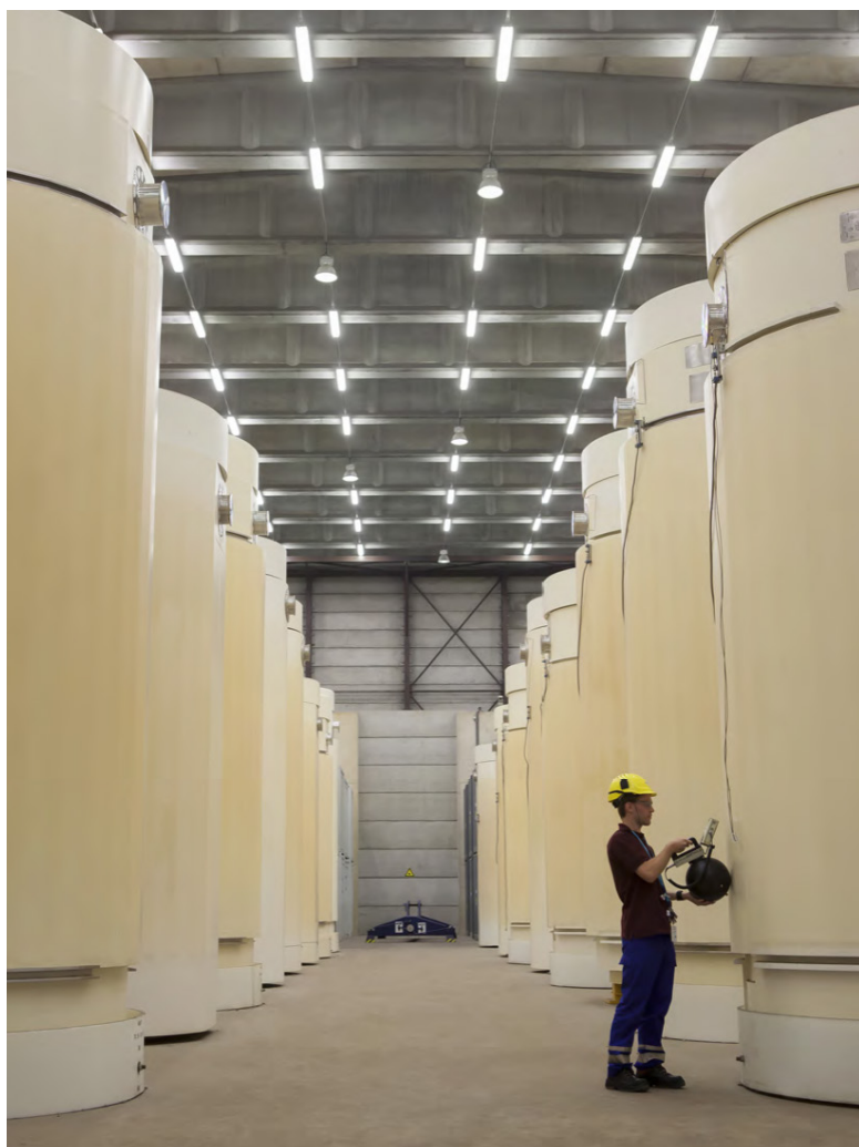
Kerncentrale van Doel. Centraal gebouw met containers voor de droge opslag van verbruikte splijstof. Fotoarchief ELECTRABEL
